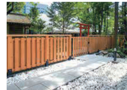
裏参道は石張舗装と砂利舗装で整備を行いました。
