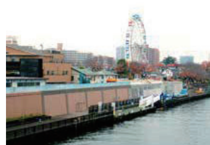
作業前の切り立った堤防と護岸
