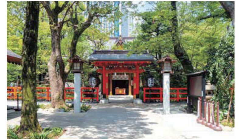
参拝客も多く訪れる愛宕神社の参道や境内の舗装工事を行いました。(男坂上り、白鳥居の先にある丹塗門)
