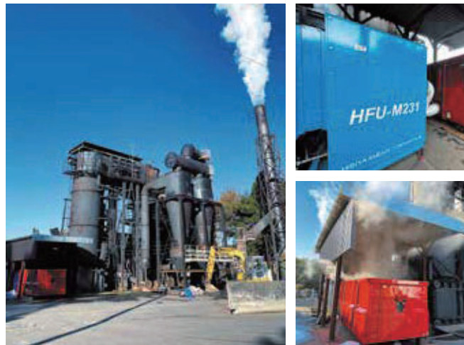
(左)焼却炉 (右上)HFUとKantainer接続の様子 (右下)木質チップ乾燥中
