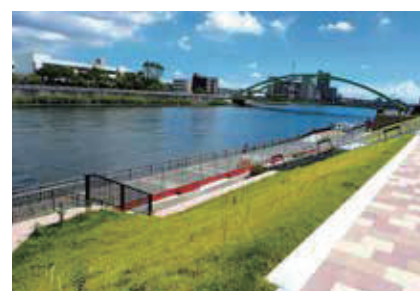
完成後に堤防の上から緑と川の景色を望む。
