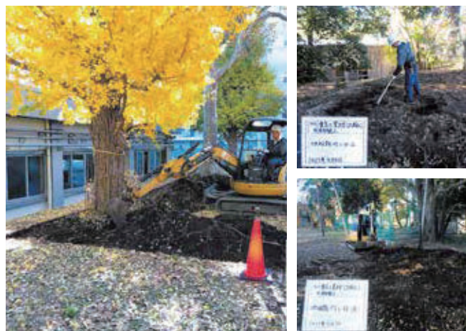
移植前は土壌分析や環境調査を実施して選定し、移植後は発生状況の経過観察を継続して行っています。
