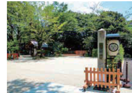
南側エリアは全面的に透水性舗装を行いました。
