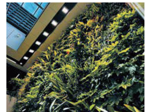
植物が健全に育成できるようbio-Light+ (植物育成用照明) を設置
