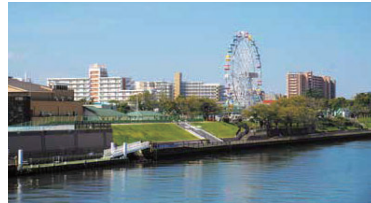
完成後に新たに生まれた緑のテラス(堤防の機能が緑の下に隠されています)
