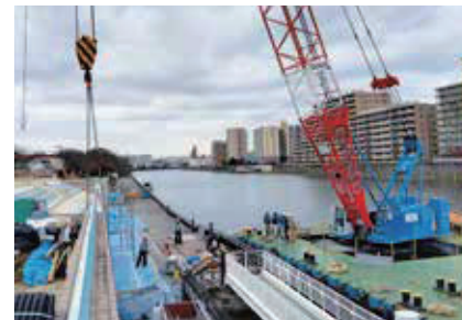
川から作業用の船を使用して工事を行いました。
