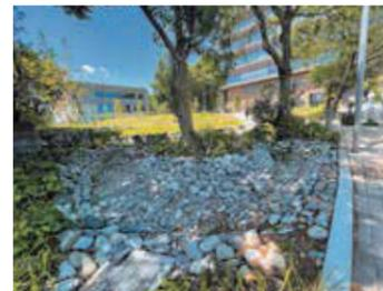
雨水流出抑制のための「レインガーデン」
