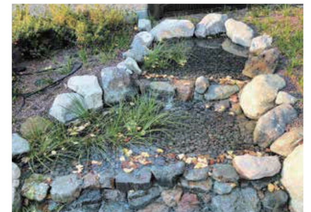
水景の越流部では、水のせせらぎの音を演出できるよう施工
