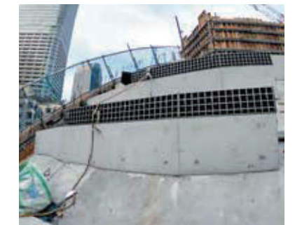
傾斜の厳しい箇所は土留め工を施します。
