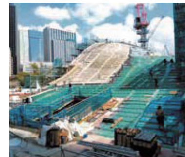
アンフィシアターの施工前
