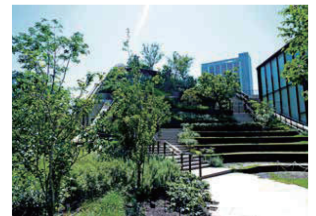
実り多く、緑に触れ合う空間が持続できるよう、意識して施工を完了しました。
